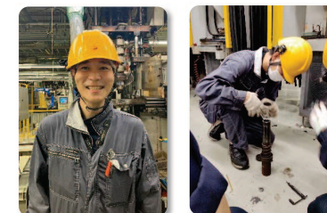
安全最優先で設備不具合対応中
