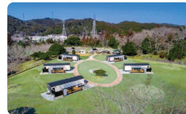
トレーラーハウス宿泊施設 完成
